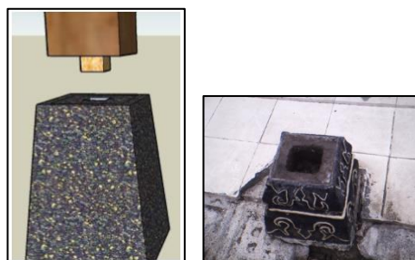
Gambar 3. Sambungan Kolom dan Umpak (kiri); Umpak kosong (kanan)
