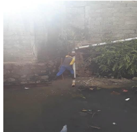
Gambar 5: Penataan Saluran Tertutup Sumber: Pribadi, 2024
