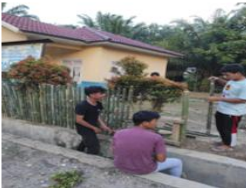
Gambar 4. Pemasangan pagar Kantor kepala Desa Ulak Tano
