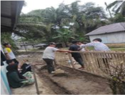
Gambar 3. Pemasangan pagar Kantor PKK
