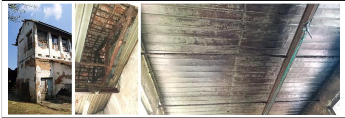
Gambar 9. Elemen Konstruksi Atap dan Langit-langit pada Abattoir Cimahi
