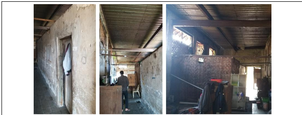
Gambar 15. Ruang di dalam Interior Abattoir dengan Penambahan Partisi secara Informal
