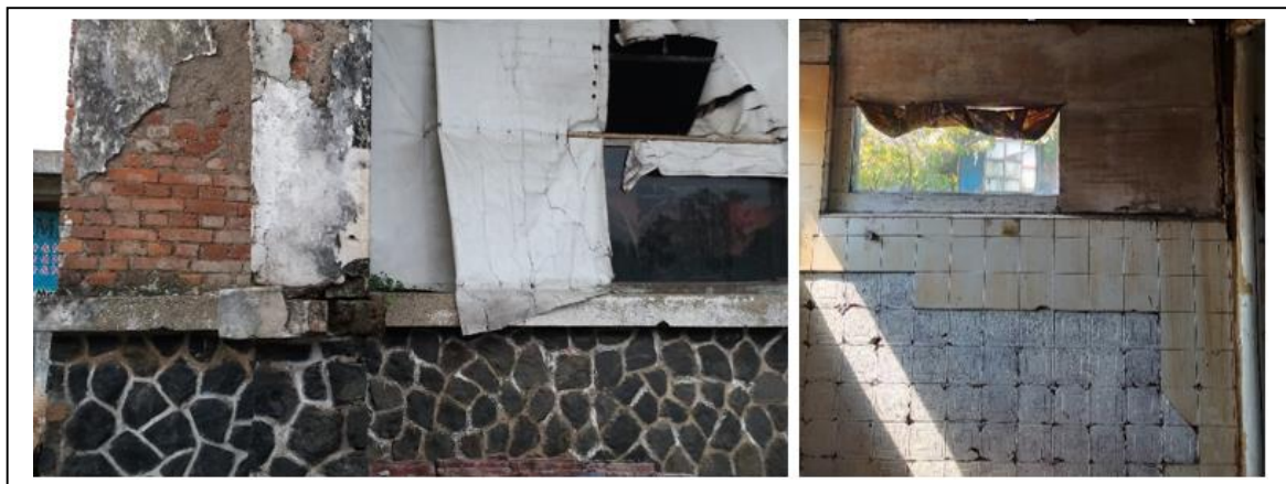
Gambar 4. Elemen Dinding pada Bagian Eksterior dan Interior Abattoir Cimahi
