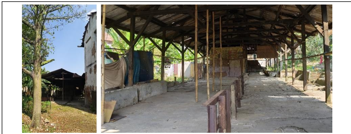
Gambar 13. Bangunan Lapang Berpeneduh di Belakang (sisi Timur) Abattoir dan Beberapa Bangunan Informal Tambahan
