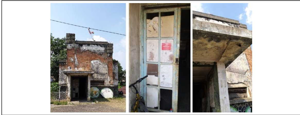
Gambar 5. Akses Utama pada Bagian Depan (Barat) Abattoir Cimahi
