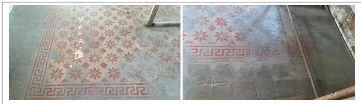
Gambar 10. Elemen Lantai pada Interior Abattoir Cimahi
