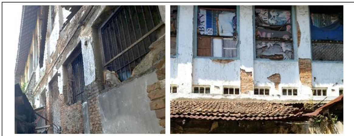
Gambar 8. Elemen Buka-an Jendela pada Bagian Basement dan Elemen Ventilasi pada Abattoir Cimahi
