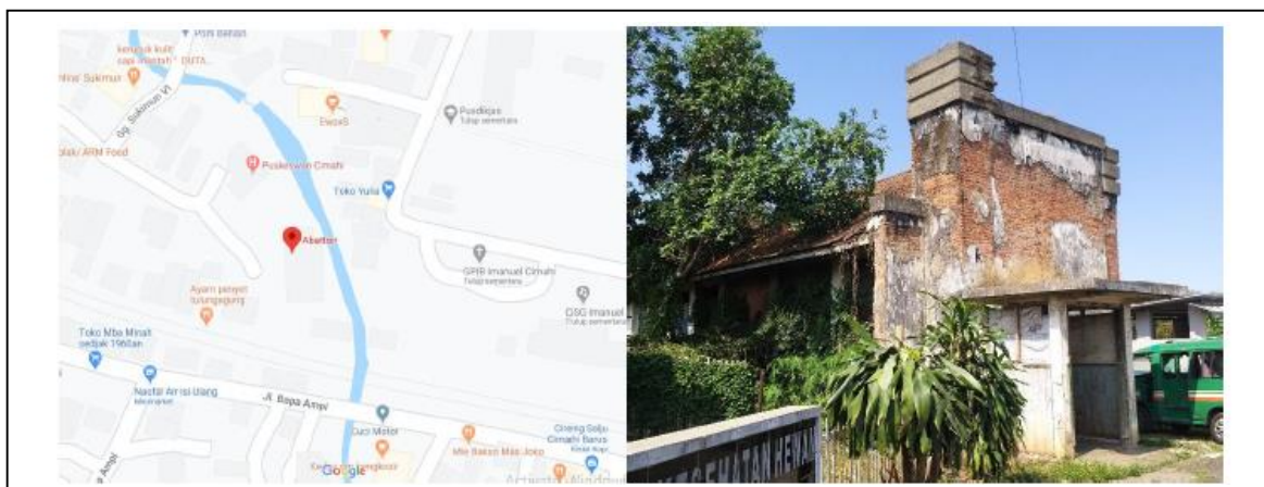
Gambar 1. Ilustrasi Lokasi Abattoir Cimahi sebagai Objek Penelitian (kiri) dan Foto Bangunan Abattoir Cimahi (kanan)
