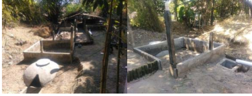
Gambar 7. Digester sudah diurug dan siap diisi Sumber : Dokumentasi, 2019.
