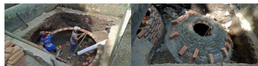
Gambar 6. Pemasangan bio-digester Sumber : Dokumentasi, 2019
