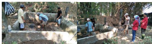
Gambar 4. Menggali tanah untuk perletakan bio digester.
